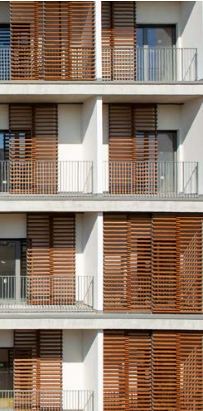
Hospital de Bari Bari (Italia) Pinearq Arquitectura
