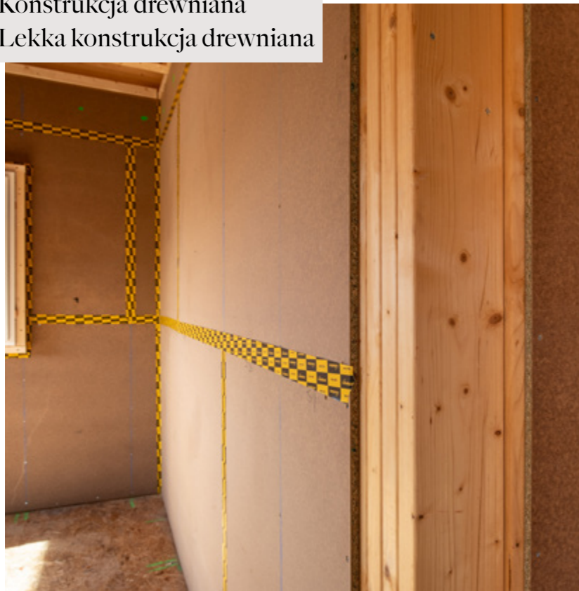
Dom Begues Energiehaus Arquitectos
