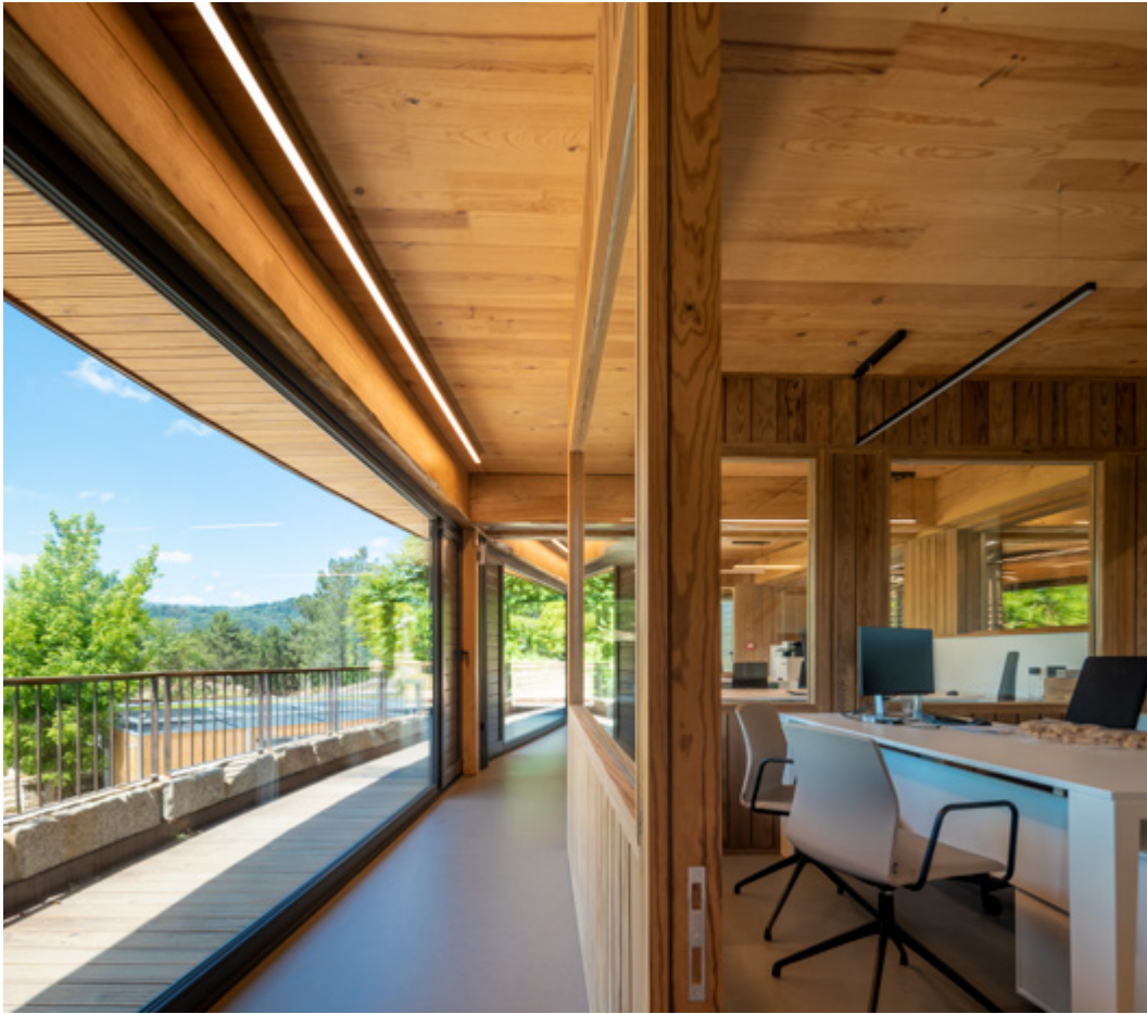
Estructura, cerramientos, revestimientos exteriores e interiores, carpinterías y decking exterior
